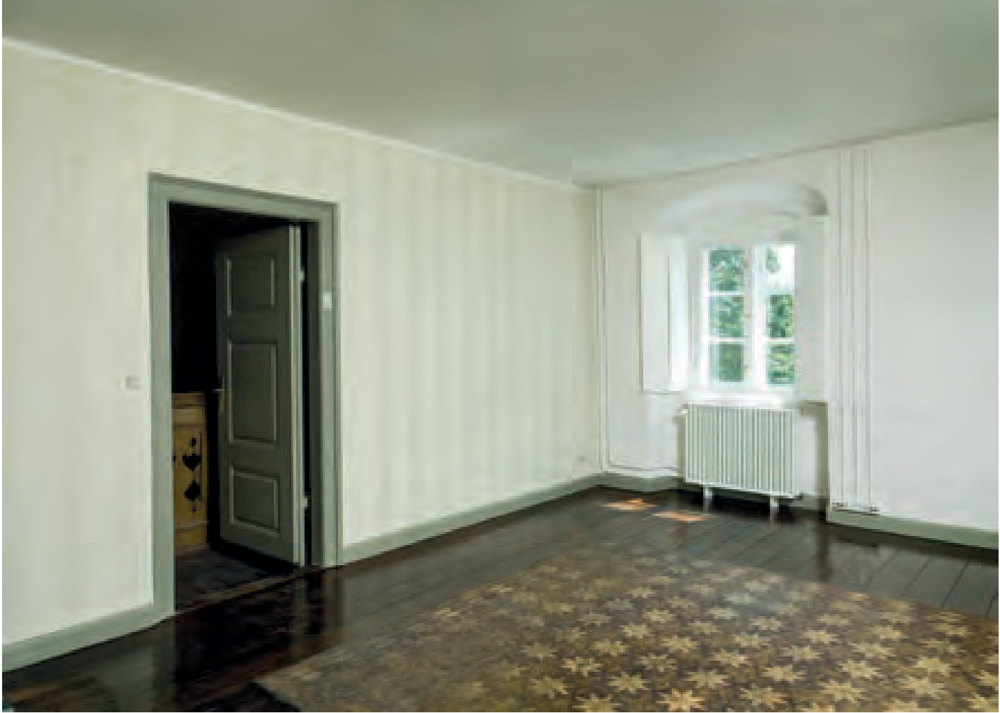
Efter restaureringen. Til træværket er valgt en farve fra konservatorernes farvetrappe, der matcher marmoreringen omkring ovnen, og til væggene et tapet fra samme periode. Foto: Roberto Fortuna.
