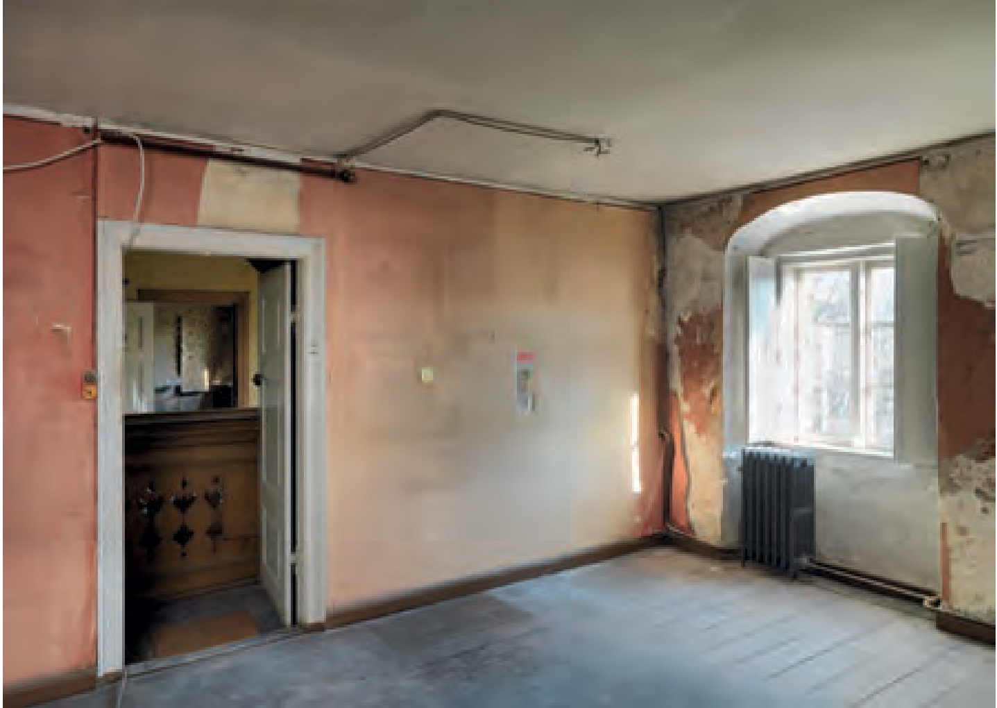
Rum 216 under restaureringen, med skygger efter den sidste frøkens tætte ophængning af billedrammer. Omkring vinduet er man nået ind til det oprindelige pudslag. Foto: Roberto Fortuna.
