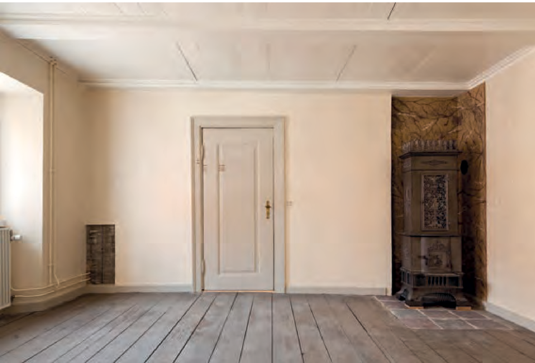
Værelse på første sal, rum 204, efter restaureringen. Tapetet er moiré, der var meget populært fra 1830'erne og de følgende hundrede år. I afdækningen ses en mønstret bræddevæg, opsat da førstesalens to store rum blev delt i værelser i første halvdel af 1700-tallet. Foto: Kurt Rodahl Hoppe.
