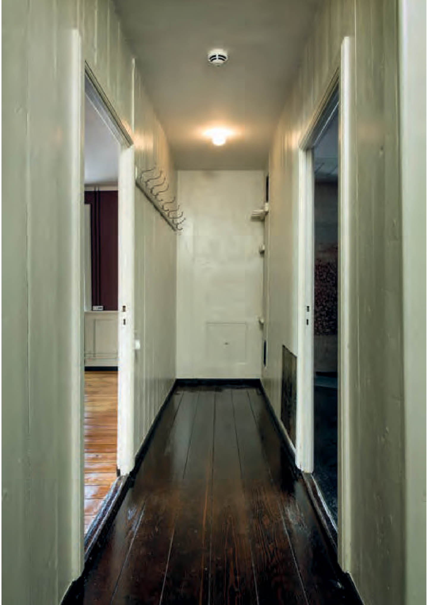
Korridor mod østgavlen rum 217a, hvor man ser skorstenen med renselem fra den tilmurede gavlkamin i stueetagen. Ligesom mange steder i huset gemmer sig her elegante, håndmalede motiver under senere tiders monokrome overmaling. Foto: Roberto Fortuna.
