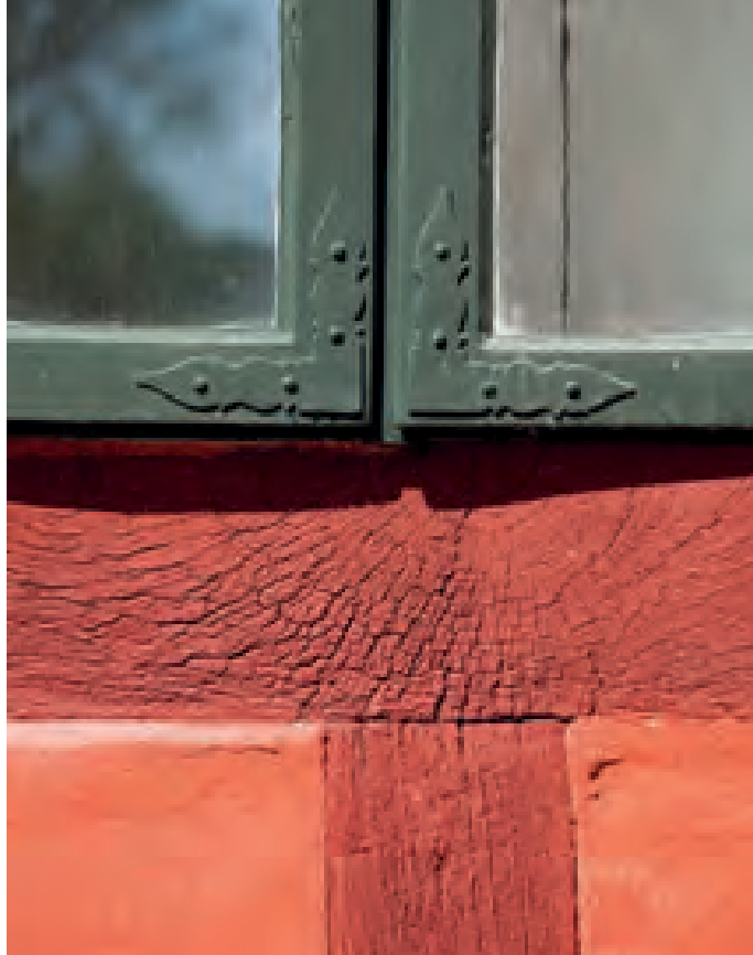
Detaljer fra østfløjen, der er opført ca. 1749 i bindingsværk med murede tavler. Under restaureringen kom den røde farve frem under mange lag hvid kalk. 2013 Foto: Kurt Rodahl Hoppe.
