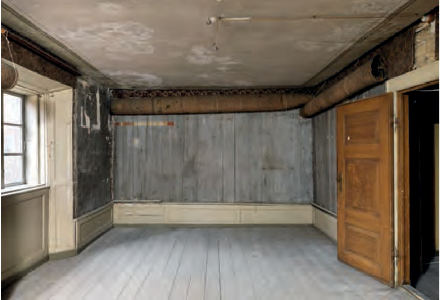
Ældre væglærreder med tapet blev rullet op i dette rum, 203, under en kort konservatorundersøgelse i 1970'erne. Bag dem var en bræddevæg, oprindeligt med rød og gul bandebemaling. Foto: Roberto Fortuna.
