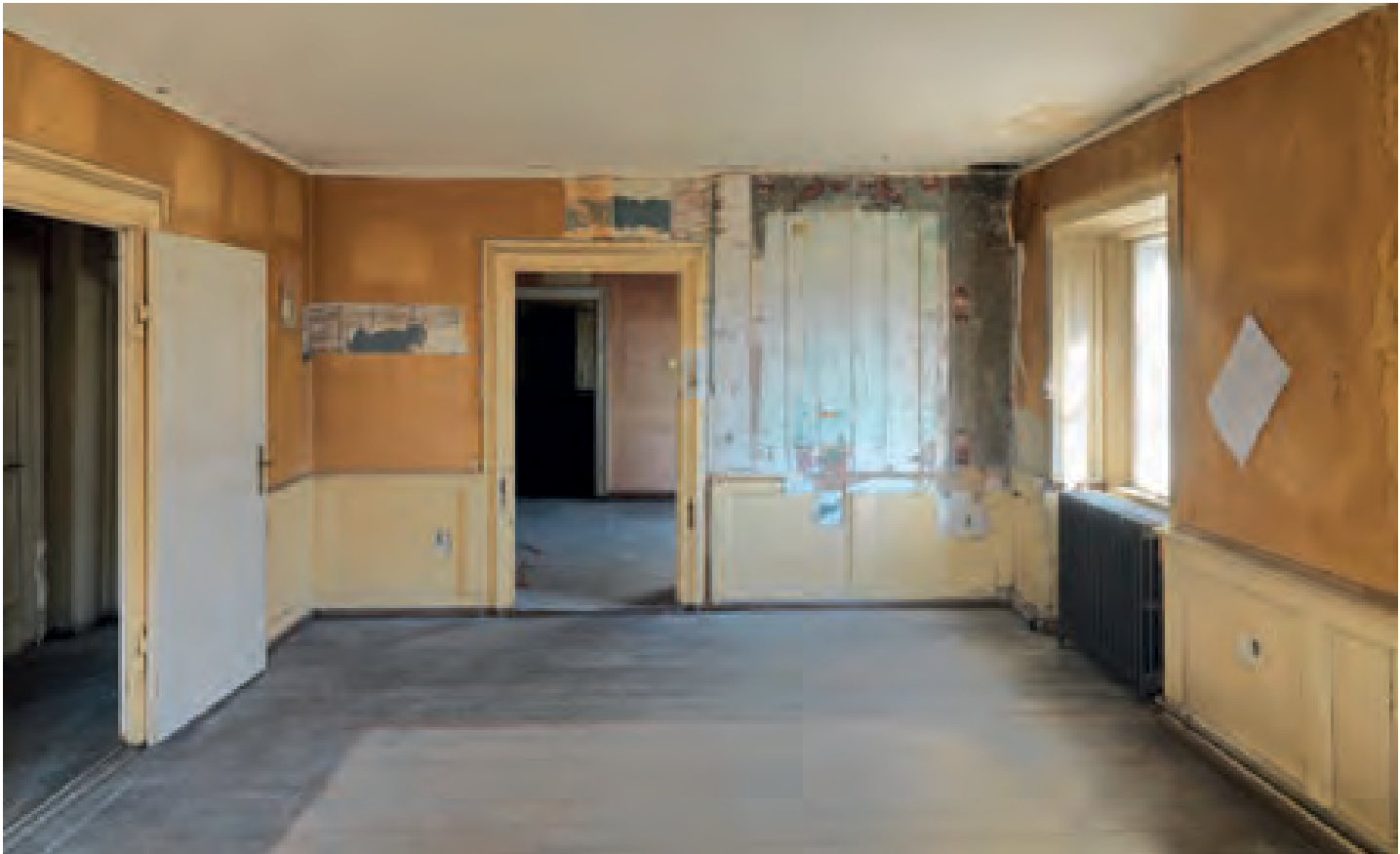
Den modsatte ende af rum 217, med bræddevæggen fra første del af 1700-tallet. Brystpanelerne med enkle fyldinger blev opsat lidt senere for at isolere og pynte. Foto: Roberto Fortuna.
