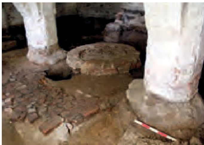
Øverst: Brønden i kælderen stammer formentlig også fra den ældre bygning. Den oprindelige middelalderlige brøndkarm i røde sten ses nederst. Nederst: Teglstensgulvet og brønden fra den ældre bygning. De fritstående hvælvpiller hviler hver på én stor kampesten. Odense Bys Museer.
