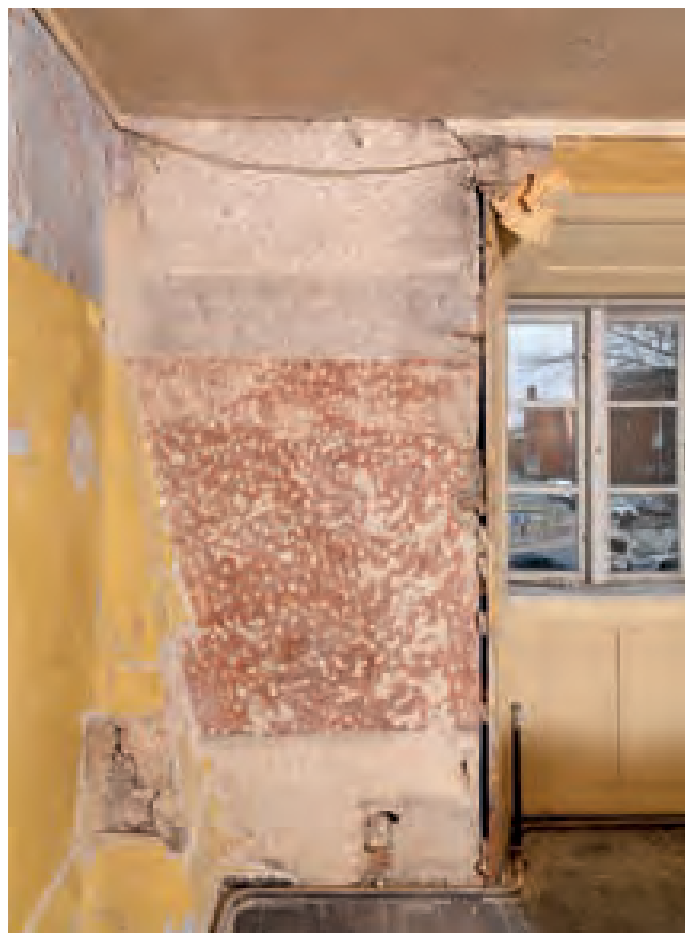
Odense Adelige Jomfrukloster. Omkring år 1600 blev overetagens sal indrettet med en malet tekstilimitation og efterligning af trukne stukprofiler, malet i limfarve med de billige pigmenter jernoxidrød og kønrøg. Foto: Roberto Fortuna 2011.
