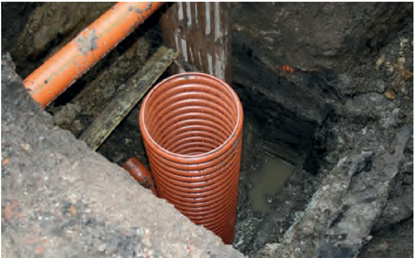
Ny i gammel. Den moderne brønd blev ved et tilfælde sat lige ned i den gamle, som det lykkedes at bevare. Odense Bys Museer.
