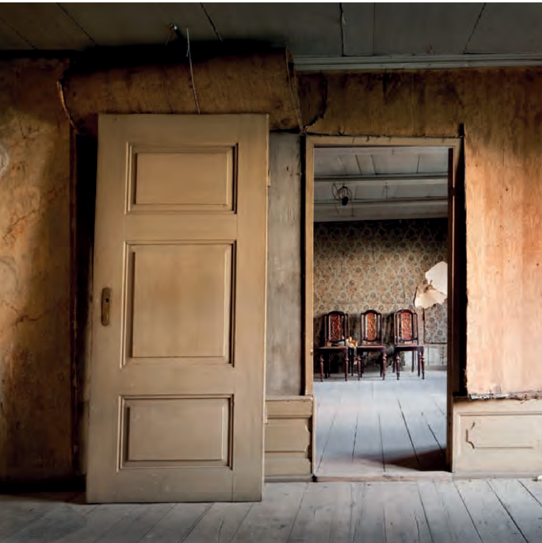
Rum 205, med kig til rum 204, før restaureringen. Foto: Kurt Rodahl Hoppe.
