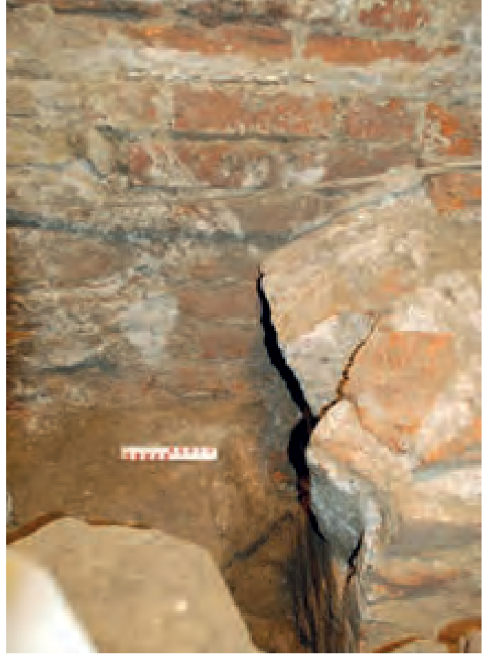
Nærbillede af hvælvpillen. Fortsættelsen af skjoldbuen ses af de manglende pudsrester. Odense Bys Museer.
