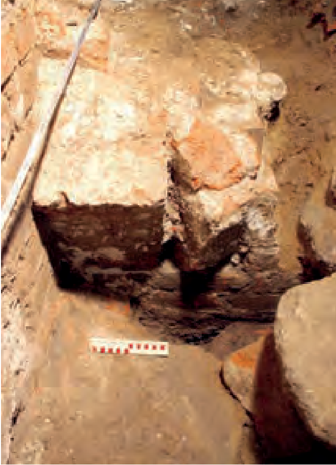
Nærbillede af hvælvpillen. Under målebåndet ses ansatsen til skjoldbuen, der har båret hvælvet langs væggen. Den skrå sten til højre herfor er ansatsen til en halvstensribbe. Odense Bys Museer.
