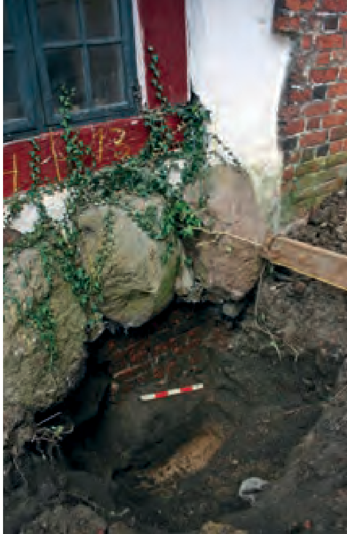
Nordøsthjørnet af østfløjen. Længst til højre gavlen af hovedbygningen og sammenføjningen med bindingsværksbygningen. De store sten under vinduet hører sammen med bindingsværksbygningen, mens murstykket nedenunder er indgået i bispegårdens port mod øst. Odense Bys Museer.
