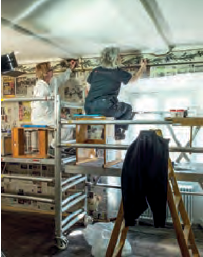
Loftbjælken langs ydervæggen i rum 213 var overtapetsret. Konservatorerne afdækkede den forsigtigt og genskabte den oprindelige dekoration, der var malet på frihånd. Foto: Roberto Fortuna. Modsatte side: Kurt Rodahl Hoppe.
