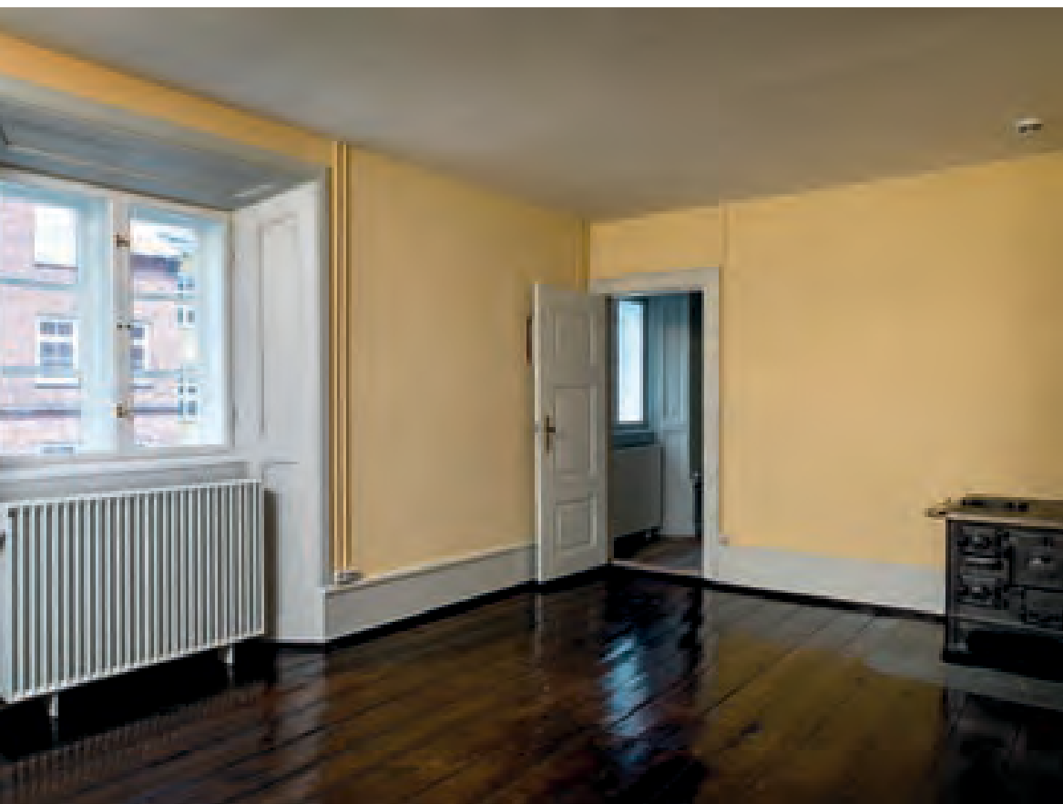
Rum 202 før og efter restaurering. Det blev indrettet som køkken i 1898, da frøkenene fik hver deres husholdning, med indbyggede skabe bag en ny skillevæg. Det lillebitte støbejernskomfur er nu istandsat, så det virker, og poleret med ovnsvæerte og Brasso, mens køkkenbordet med vask ved vinduet er fjernet. Foto: Roberto Fortuna.
