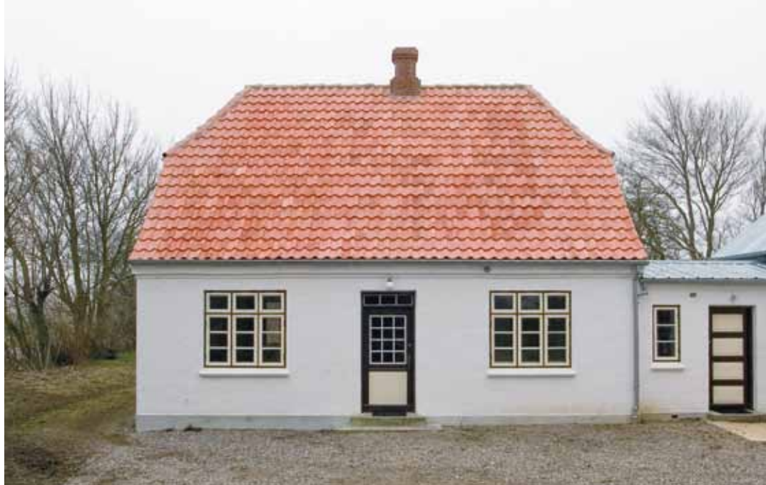
Stuehusets facade mod nord, med mellembbygningen til højre. 2012.
