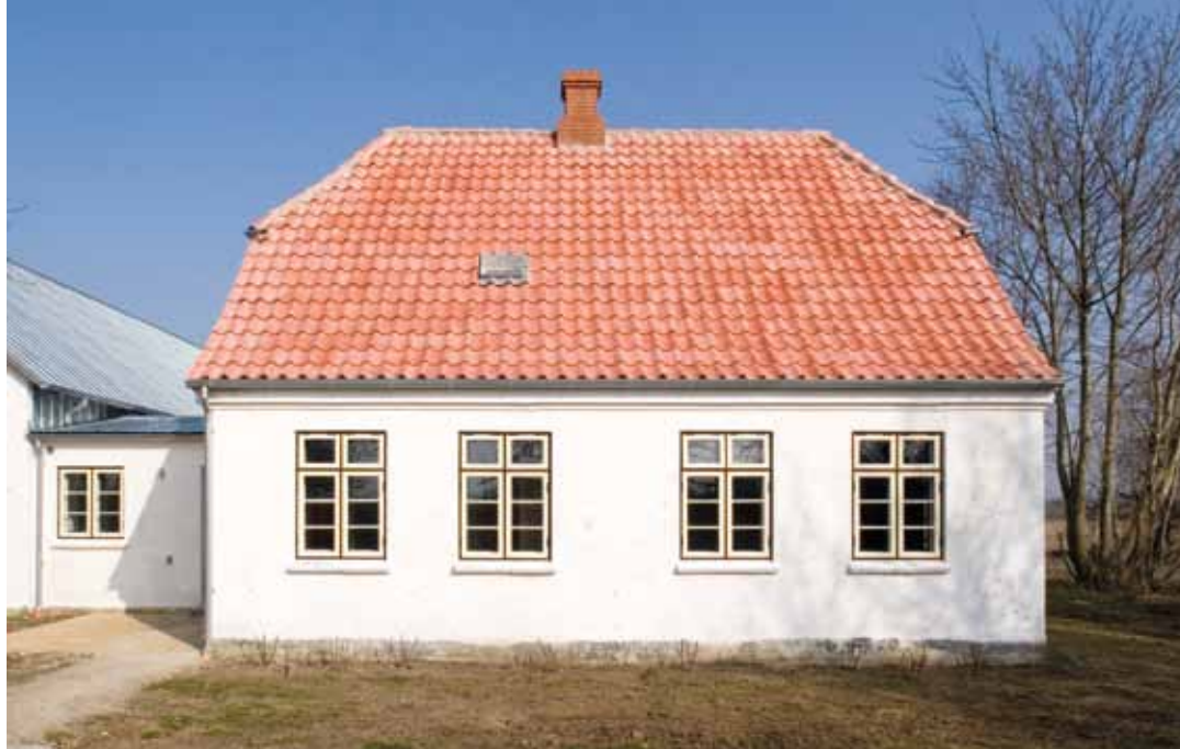
Stuehusets facade mod syd med mellembygningen til venstre, hvor også avlsbygningslængen anes. 2012.
