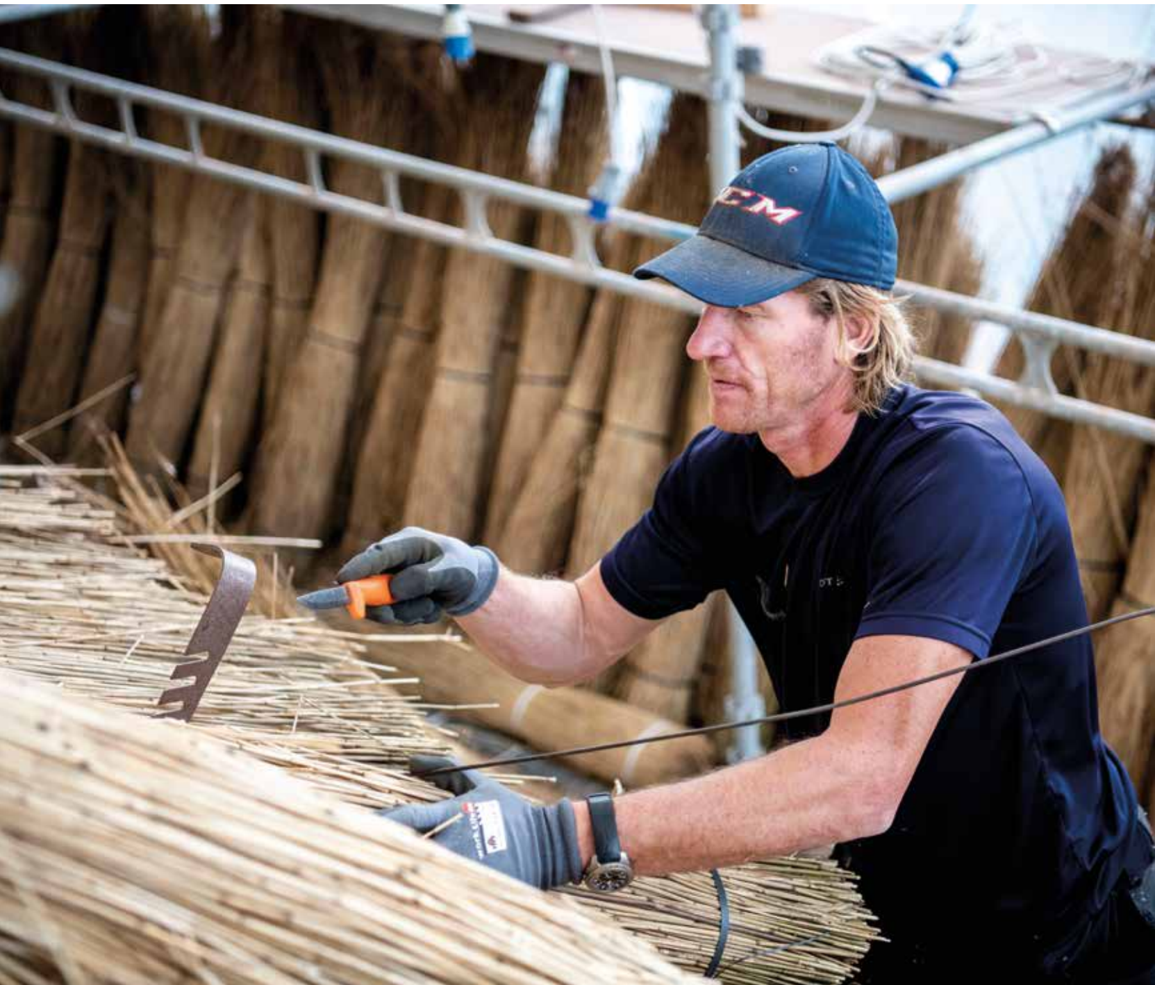
Det er tækkemand Kim Andersen, som har stået for at lægge det nye stråtag på det gamle stuehus. Til det store tag er brugt 6.000 bundter danske tækkerør, 1.200 meter fyrretræslægter og næsten 400 stykker græstørv.
