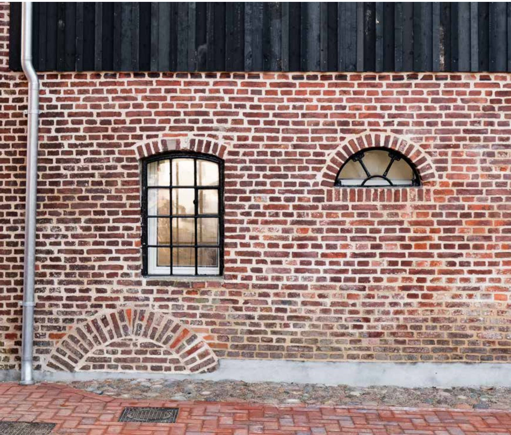
Laden er opført i 1700-tallet og er ligesom stuehuset grundmuret i krydsforbandt og med mørkerøde teglsten. Flere af de oprindelige halvrunde støbejernsvinduer er bevaret.
