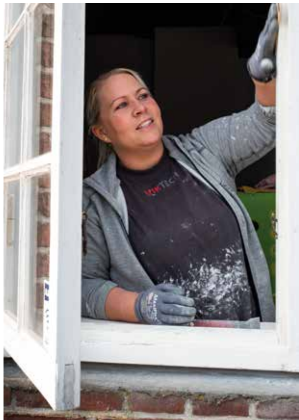
Alle vinduer er malet med linoljemaling – både de restaurerede vinduer og de nye snedkerfremstillede.
