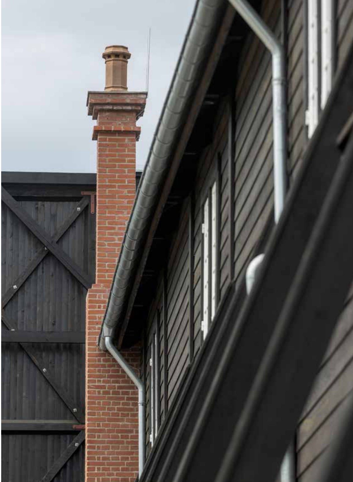
Ballonhangaren fra 1917 er sikret og bevaret via en gennemgribende restaurering.
